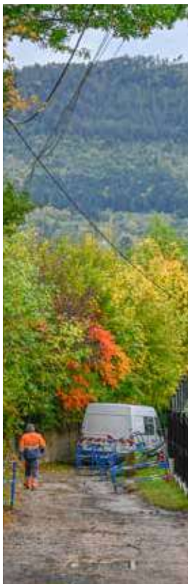
Le chemin des Bouquets est en travaux.
