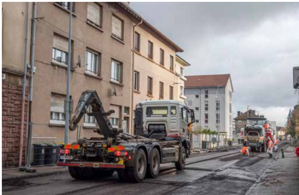
Attendus, les travaux de la rue de la Ménantille ont commencé mi-novembre.
