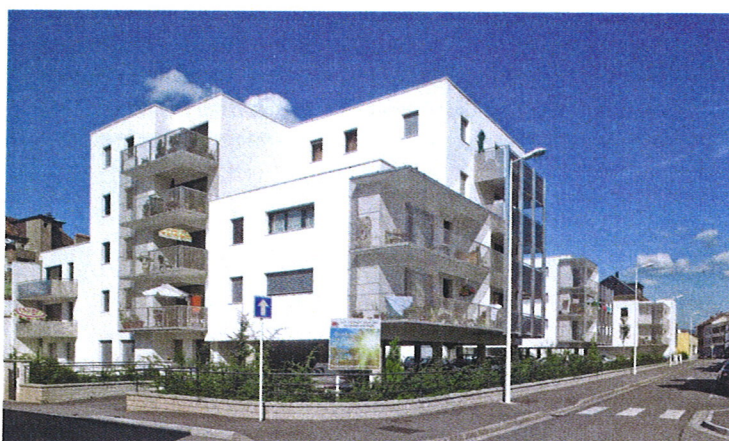
Immeuble HLM à énergie positive construit lors de la rénovation du quartier Kellermann
